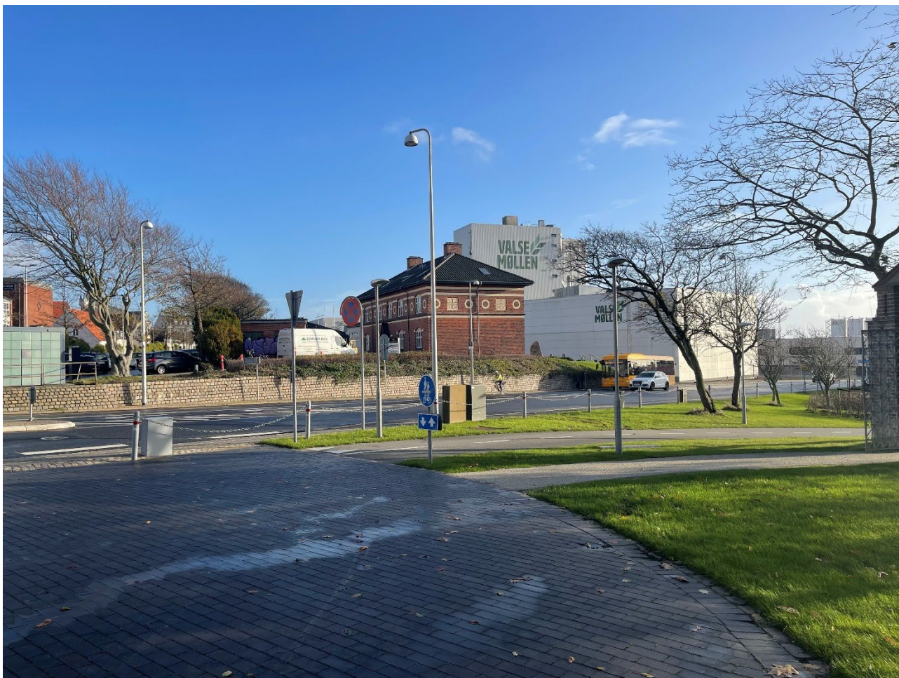
Figur 40 - På billedet ses Stormgade med adgang ned til havneområdet. I baggrunden ses nogle af de havnevirksomheder, der eksisterer i området i dag.
