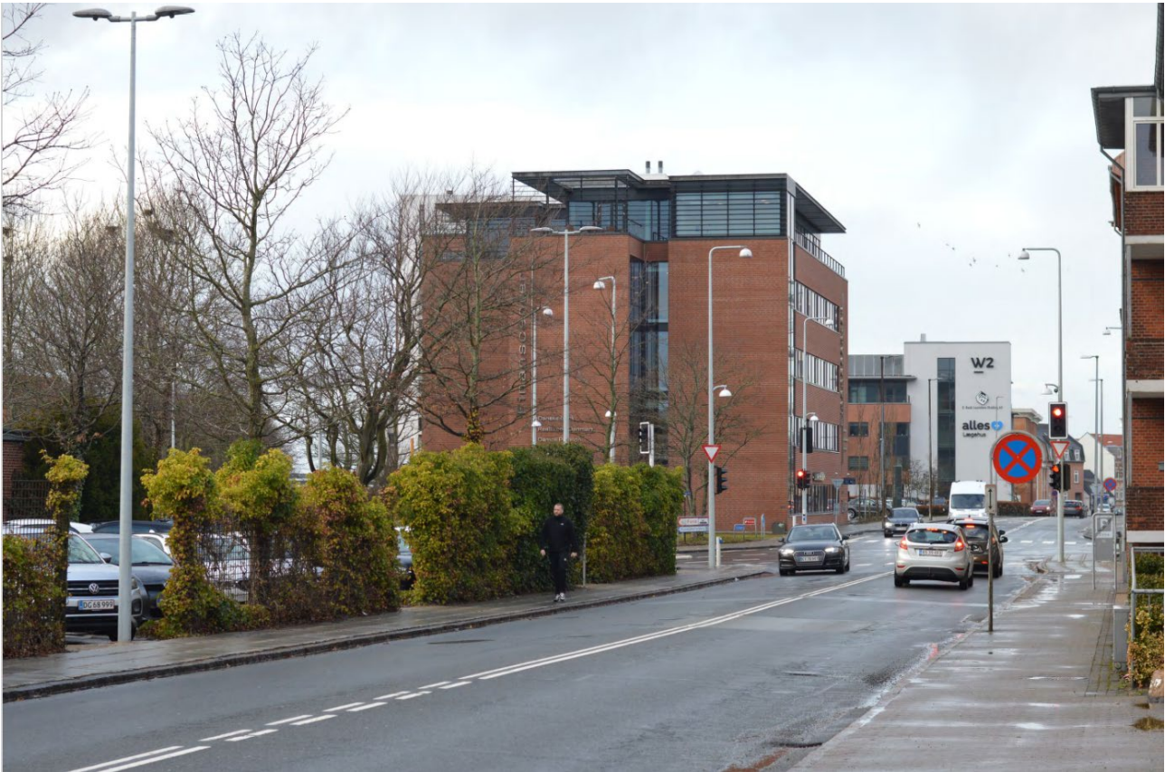
Figur 83 - Fotopunkt 4 - Eksisterende forhold.
