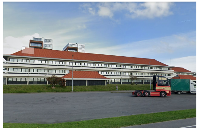
Figur 25 - Kontorbygning sydvest for planområdet set fra Adgangsvejen.
